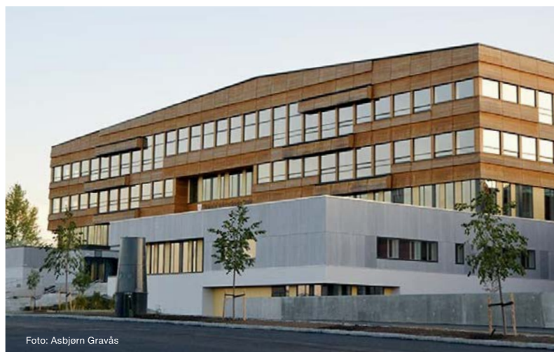
Norges första nollenergiskola Heimdal gymnasium i Trondheim. Ventilationen var en av nycklarna i projektet för att nå lägsta möjliga energianvändning. IV Produkt levererade 54 toppanslutna aggregat med hög värmeåtervinning och ett SFP-tal på 0,5.
