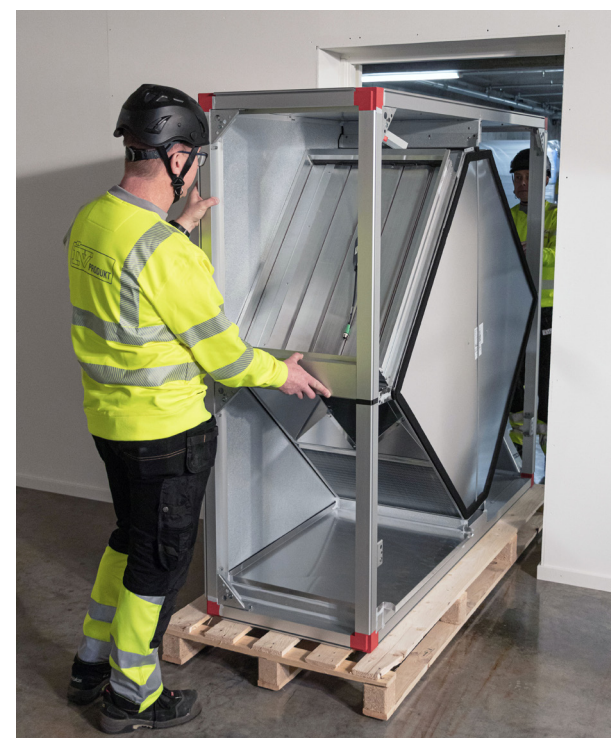
Den delade motströmsvärmväxlaren transporteras in genom en 90 cm bred dörröppning.
