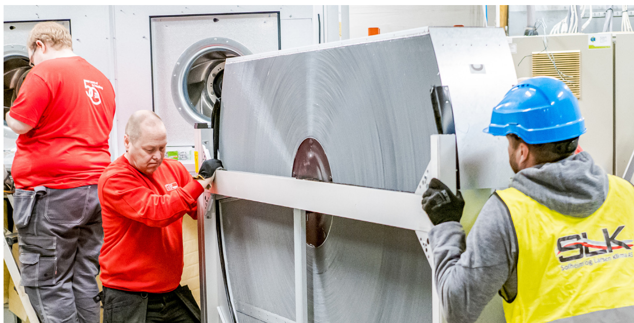
Medarbetare från IV Produkt och Solheim og Larsen Klima AS hjälps åt att transportera in den delade roterande värmväxlaren.
