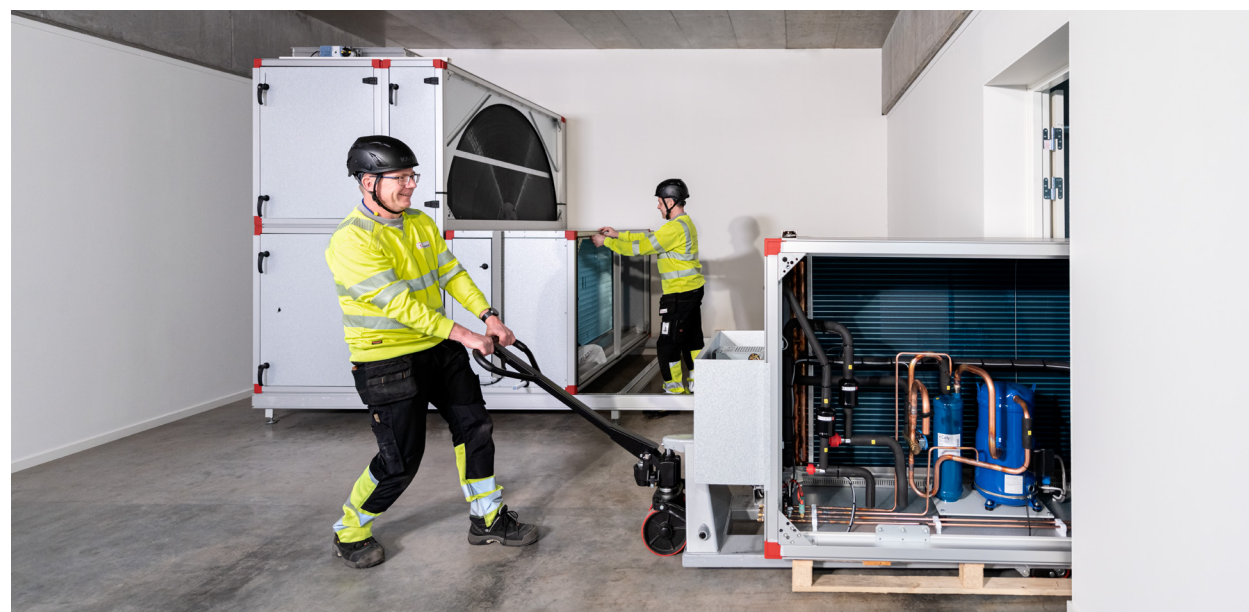
Pär och Ola från IV Produkt transporterar in ett Envistar Flex-aggregat i storlek 600 med den integrerade kylvärmepumpen ThermoCooler HP genom en vanlig dörr.
