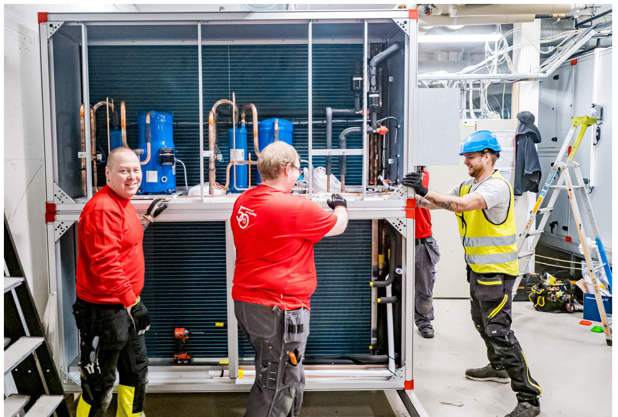
Den delbara, integrerade kylvärmepumpen ThermoCooler HP sätts på plats.
