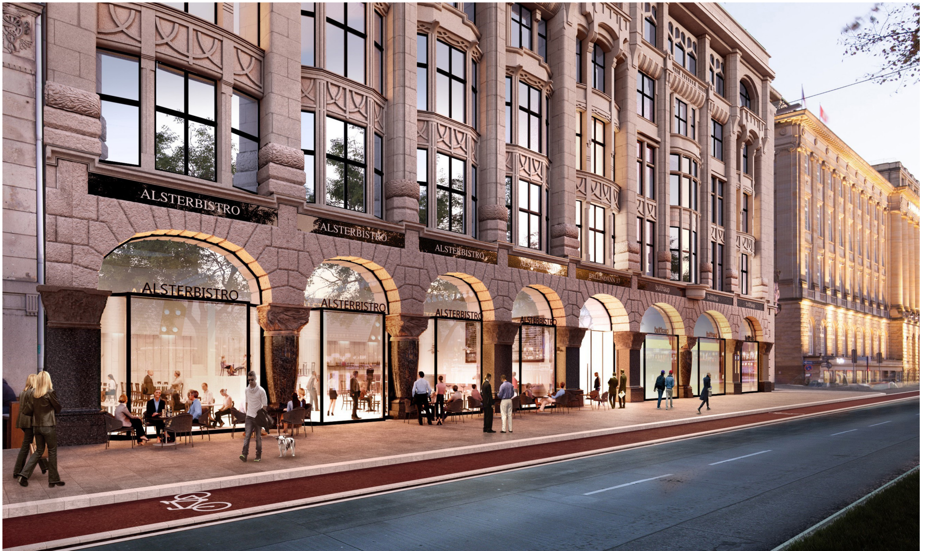
Ett behagligt inomhusklimat genereras av ett trettiotal aggregat från IV Produkts Envistar-serie till den prestigefulla byggnaden på Ballindamm 17 i Hamburg.
